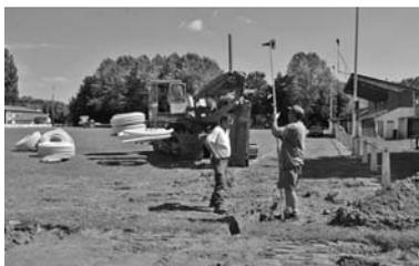
Après un désherbage total réalisé par les employés de la mairie, une entreprise spécialisée a réalisé les travaux de drainage systématique. Le sol a ensuite été reprofilé avant qu'une nouvelle pelouse soit implantée.
